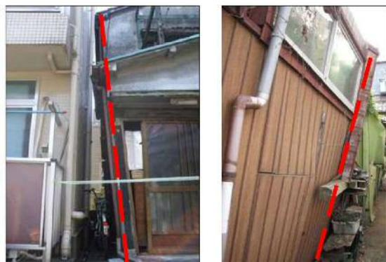
柱の変形が著しく倒壊の危険がある家屋(特定空家)
