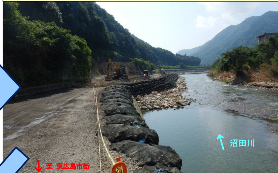
袋詰玉石工により仮設護岸の応急工事中(平成30年8月2日)
