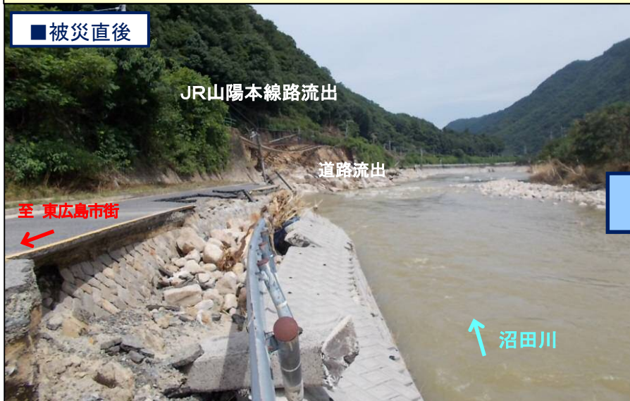
豪雨により沼田川が氾濫 JR山陽本線及び県道が流出
