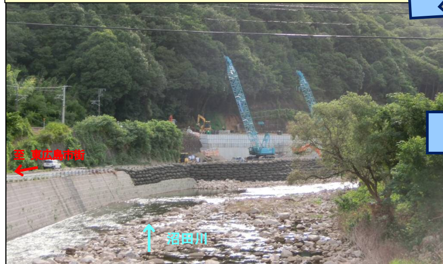
JR山陽本線復旧工事中(平成30年8月22日)
