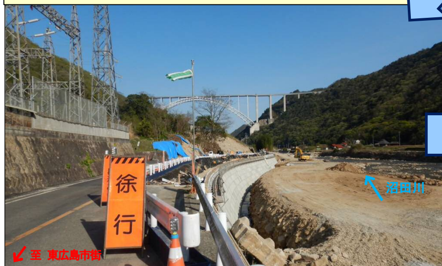
道路災害復旧工事中 (平成31年4月2日)
