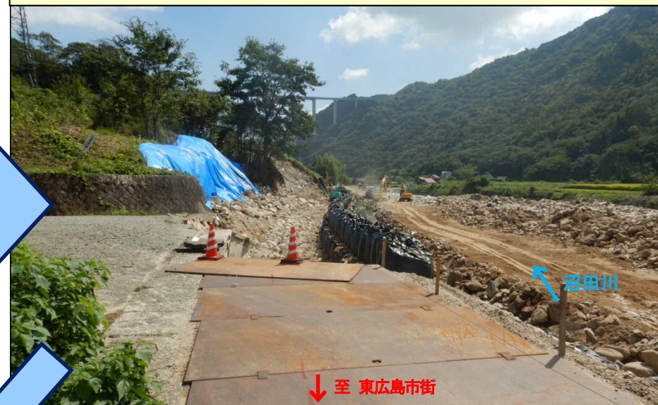
大型土のうにより仮設護岸の応急工事中(平成30年9月18日)
