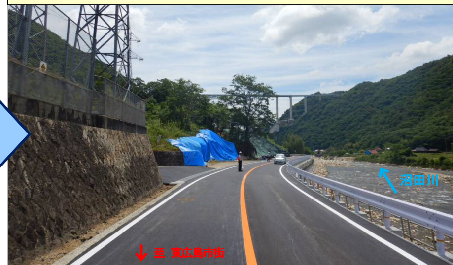
(主)瀬野川福富本郷線 完成(令和元年6月17日2車線開通)
