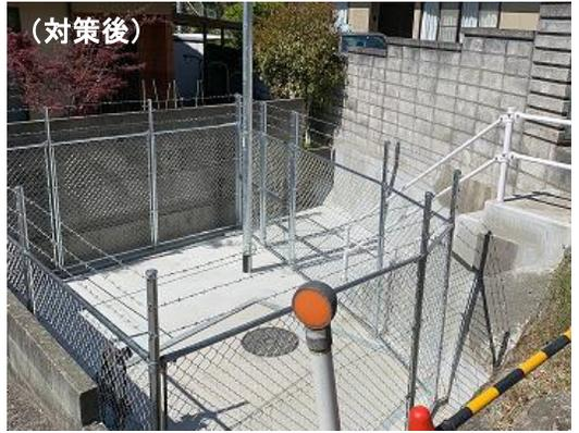
【土砂災害対策（コンクリートブロック設置：熊野調整池）】
