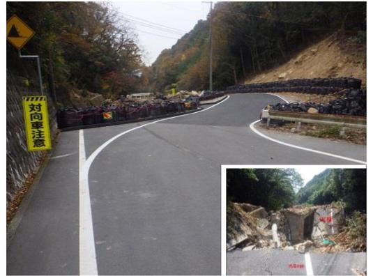
落橋した箇所について応急対応により迂回路設置
