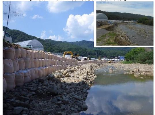
護岸が崩壊した箇所について応急対応により大型土嚢設置
