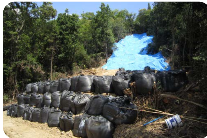
▲災害関連緊急急傾斜地崩壊対策事業
