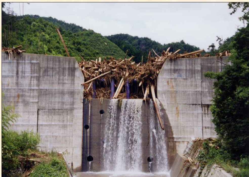
砂防堰堤工の事例
