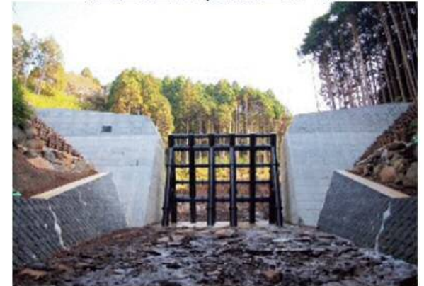
透過型堰堤施工事例
