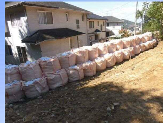
応急対策工：大型土のう
