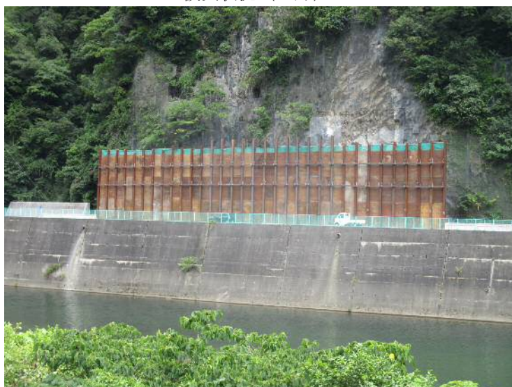
仮設防護柵の設置状況（7月）
