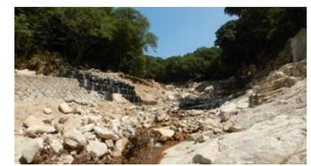
7月豪雨により天地川石積砂防堰堤が大規模に被災したことに伴い、石積砂防堰堤のうち重要度の高い石積砂防堰堤については、今後すみやかに補強を行う必要がある。
