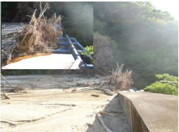
7月豪雨では、複数の土石流が発生したことにより、下流域に大量の土砂や流木が流下した。特に流木が河道内に大量に堆積したり、橋梁に阻害され上流側の河道が埋塞し、下流域に土砂や流水が氾濫・堆積した。
