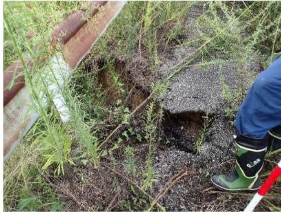
<天端～川裏のり肩の陥没>
