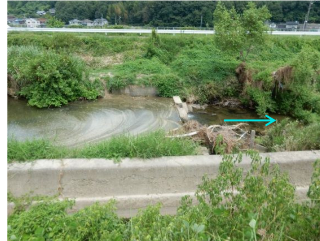
＜②破堤地点直下の固定堰＞
