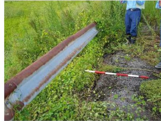
<川裏のり肩部の侵食状況>
