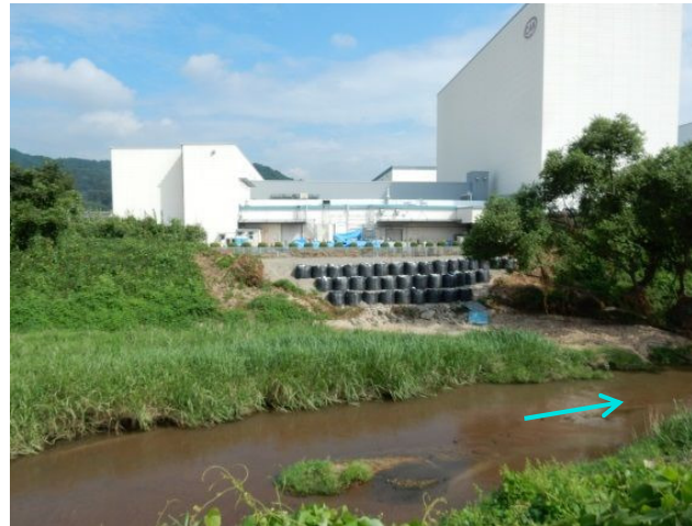
<①破堤地点の河道内状況>
