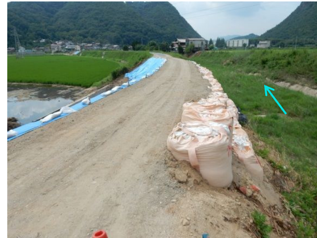
<②破堤地点の状況 (0.7k左岸付近)>
