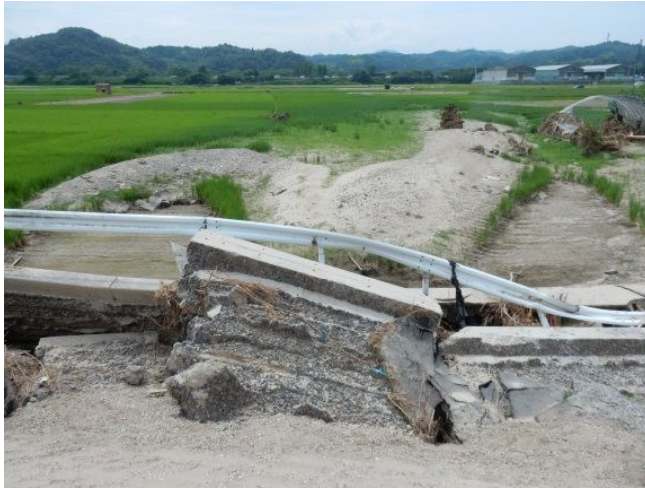
＜①破堤地点の堤内地状況＞
