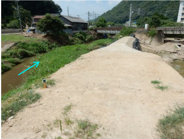
<①破堤地点の状況 (0.1k右岸付近)>
