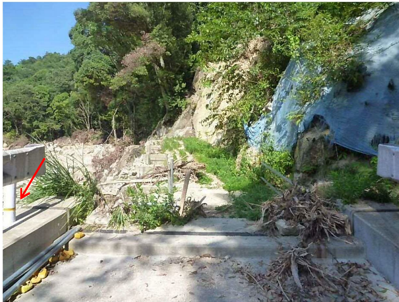
左岸側の洪水痕跡
