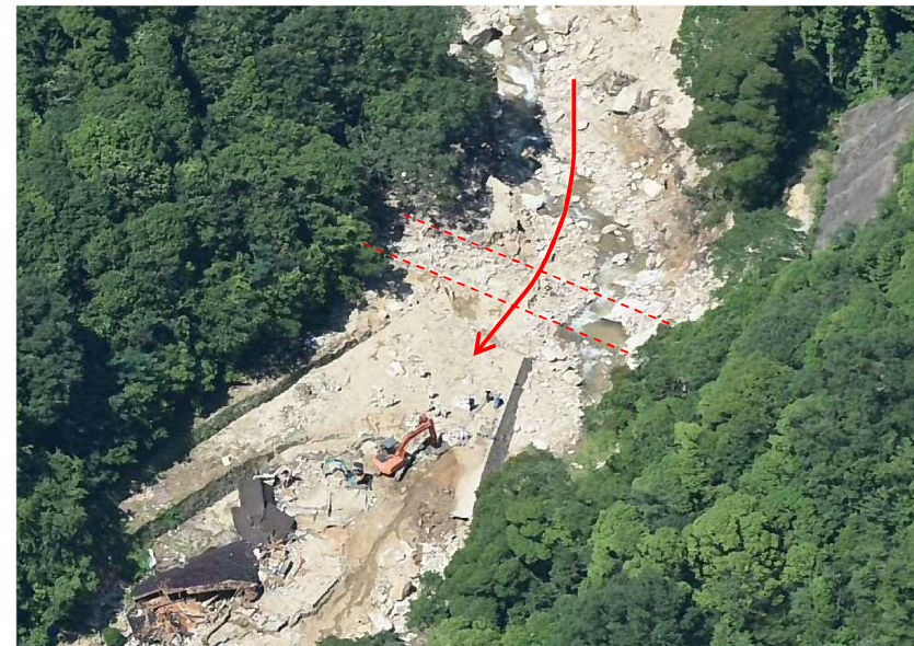
石積堰堤地点は湾曲部となっている
