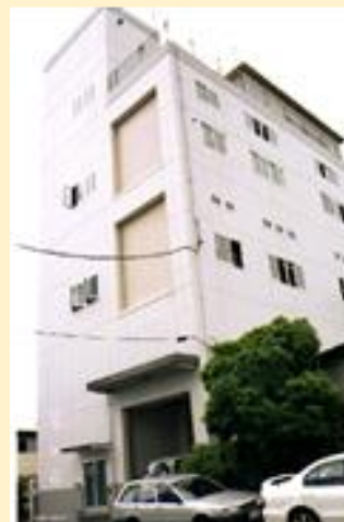
空調管理が整っている本社工場
