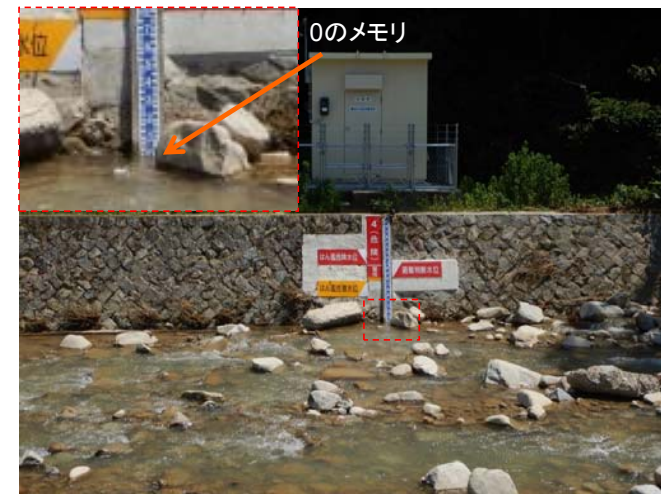
藤浪水位局(出水後)
