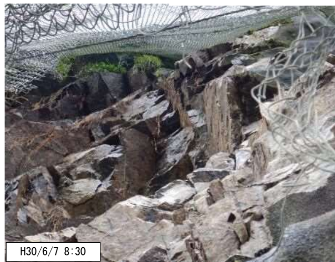
写真2-7 崩壊上部周辺の岩盤湿り状況
