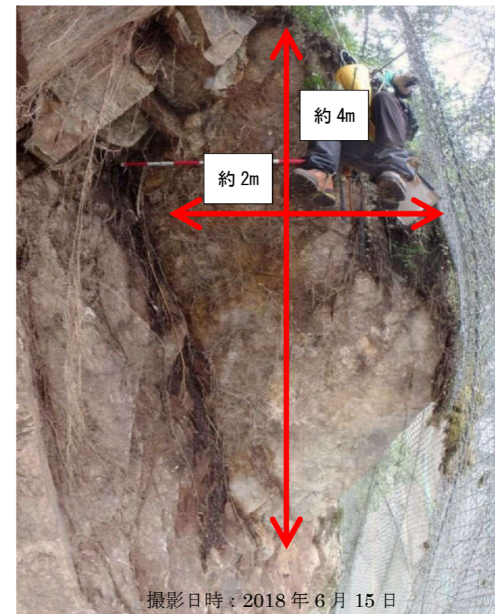
写真-3-1 崩壊斜面上部の亀裂状況
