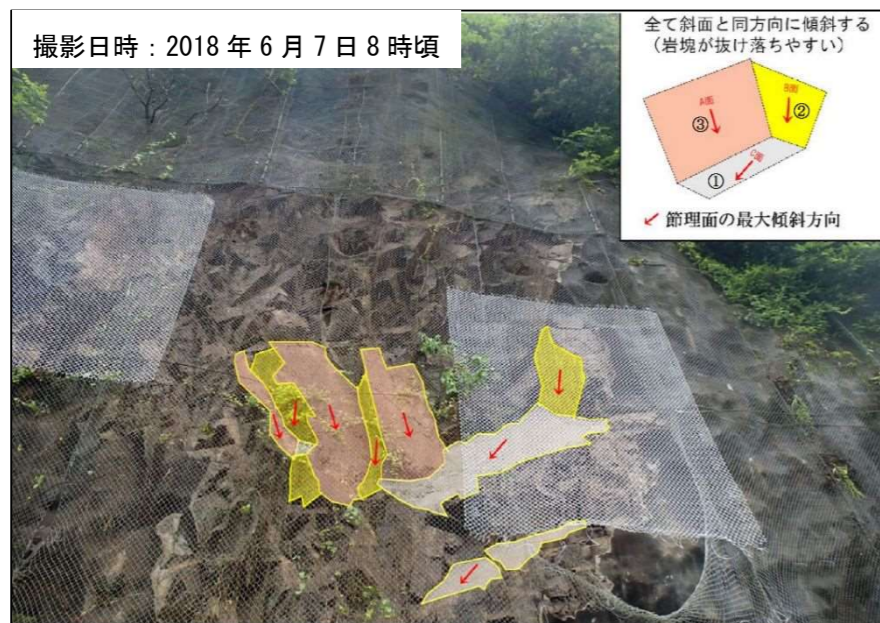
（写真1-4：節理面は斜面に対して「流れ盤」となる。）
