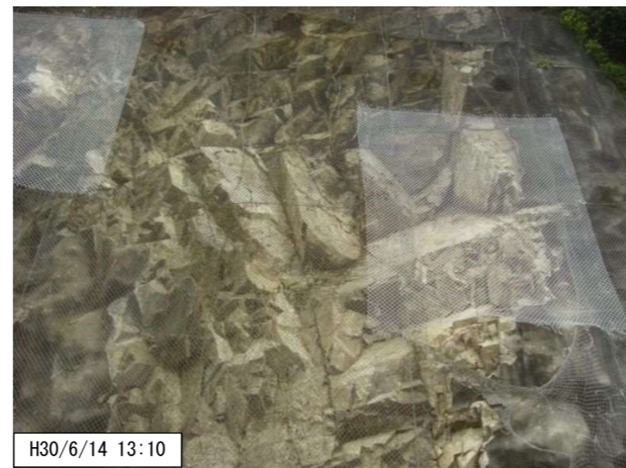
写真2-8 節理沿いに亀裂が発達した崩壊面。一部に緩みが確認される。
