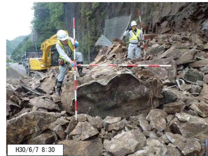
写真2-9 崩壊した岩塊状況 最大（2.0m×1.0m×1.0m）
