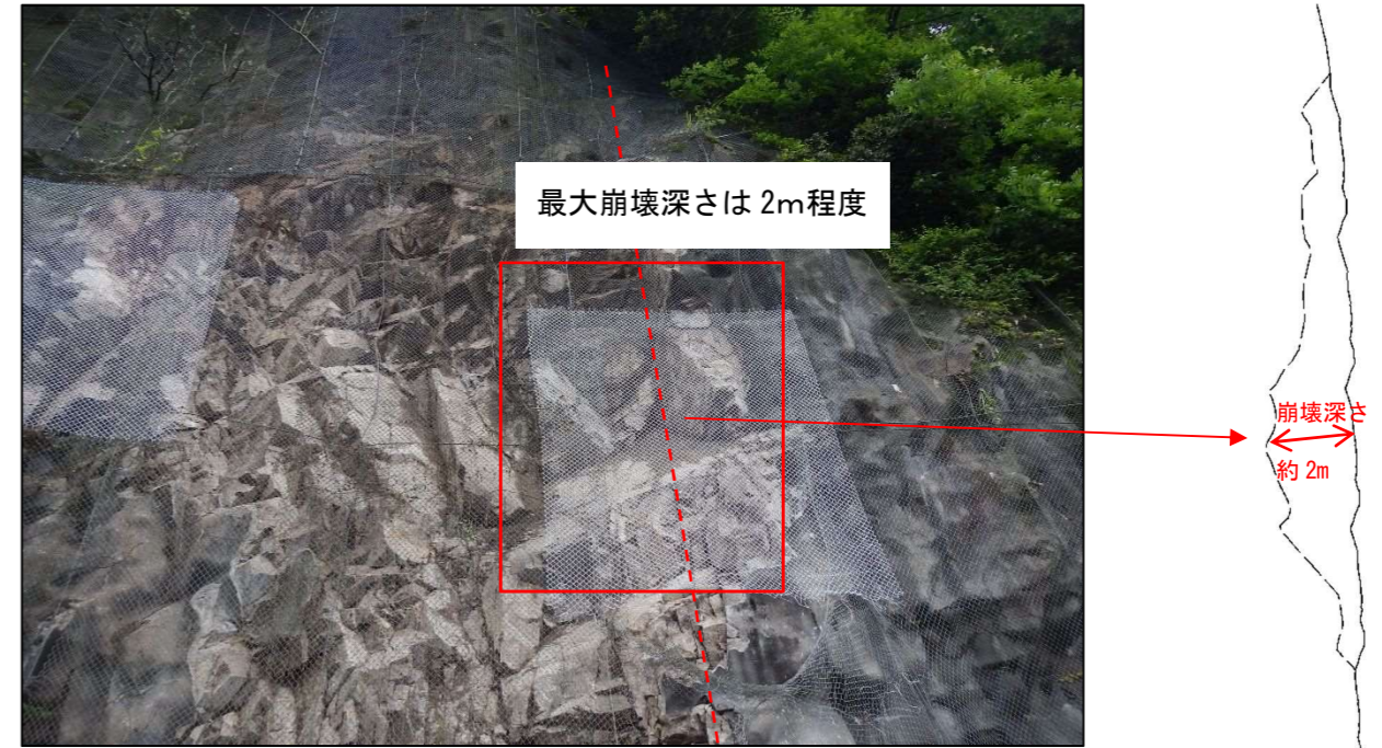
写真-2-12 崩壊状況
