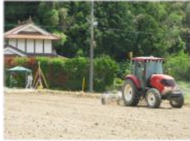
図1 傾斜施工状況(5/23)
