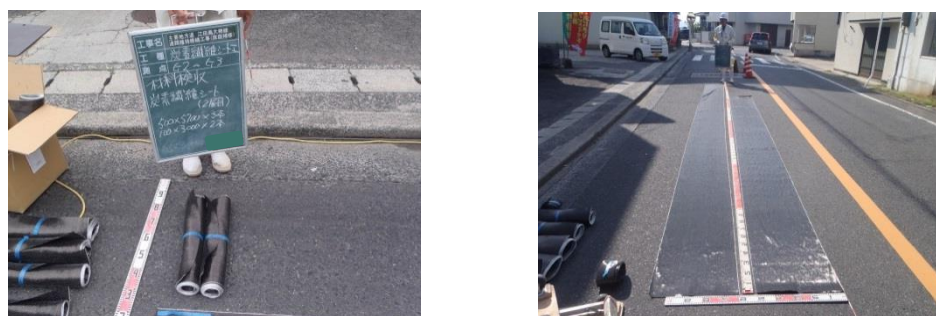
炭素繊維シート材料の確認
