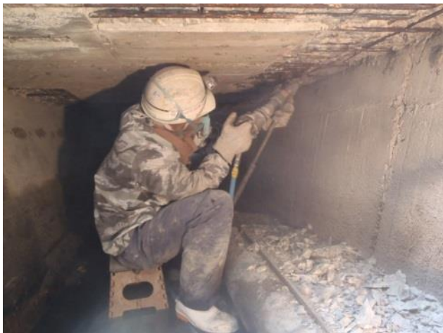
鉄筋を覆うコンクリートを取り除きます。
