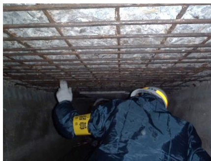
エアーを吹付清掃後、さび落とし具合などを確認します。
