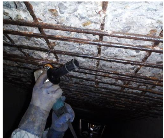
鉄筋の錆を全て削り落とします。
