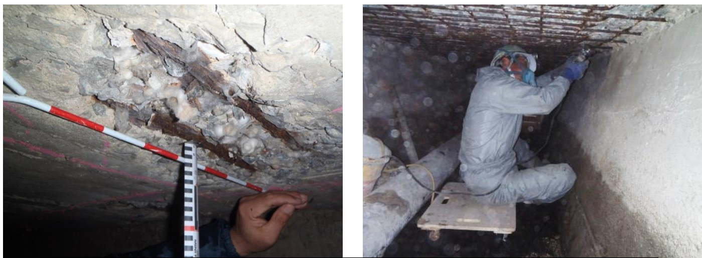
床版の劣化・損傷状況（左）と表面のコンクリートを取り去った鉄筋の状態（右）
