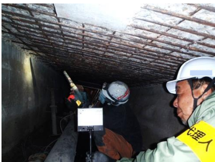
エアーを吹付清掃後、さび落とし具合などを確認します。
