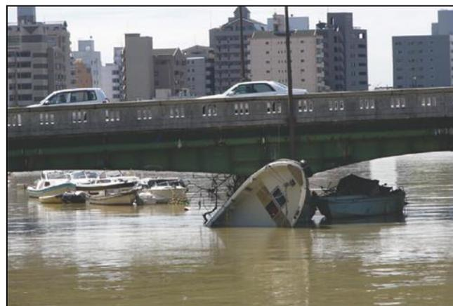
放置艇が橋脚に衝突⇒流水阻害や油漏れ，橋脚の破壊等を引き越す。
