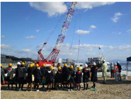
クレーンを使った作業を見守る小学生
