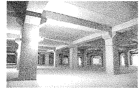
雨水貯留施設内部の様子
