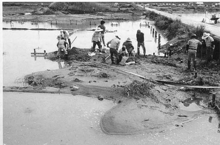
洪水の後、復旧作業の開始 昭和61年5月
