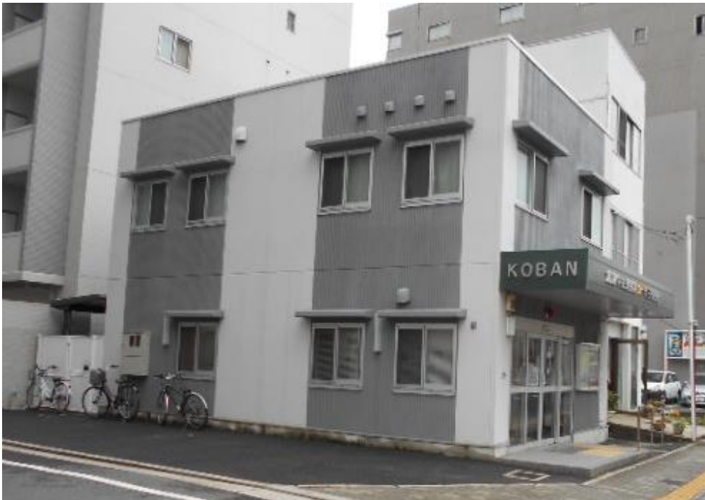
広島中央警察署十日市交番（平成 23 年建築）
