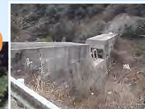
【災害前の状況】
