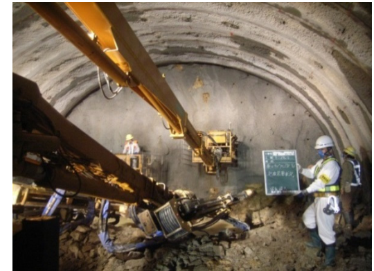
熊野黒瀬トンネル
