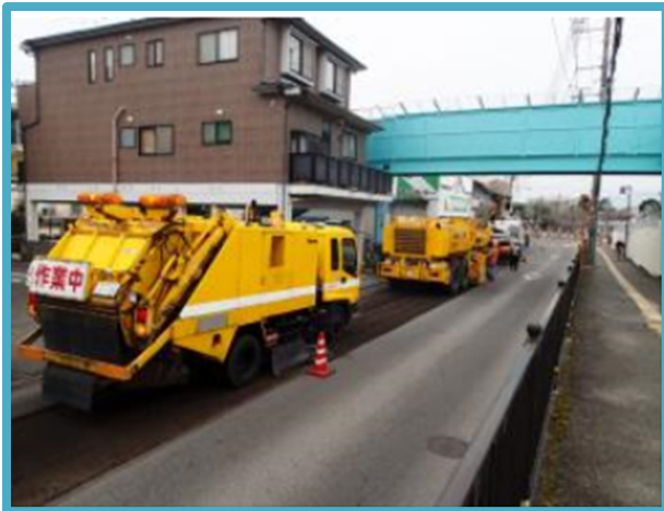
ほそう ほしゅう 舗装の補修
