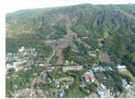
台風26号による土砂災害 (平成25年10月18日 伊豆大島)
