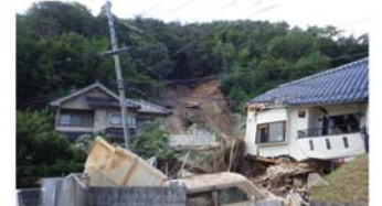
がけ崩れ被災状況 (平成26年8月20日 広島市安佐北区)
