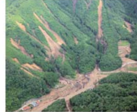
局地的な豪雨による土砂災害 (平成22年7月16日 庄原市)
