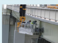
橋梁の点検状況
