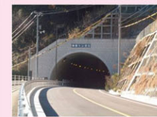
道路改良工事例(バイパス整備)
