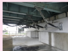
橋梁耐震工事例(落橋防止)
