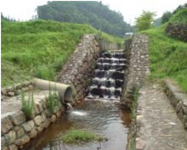
【排水路区間に設けられた遊水地】
