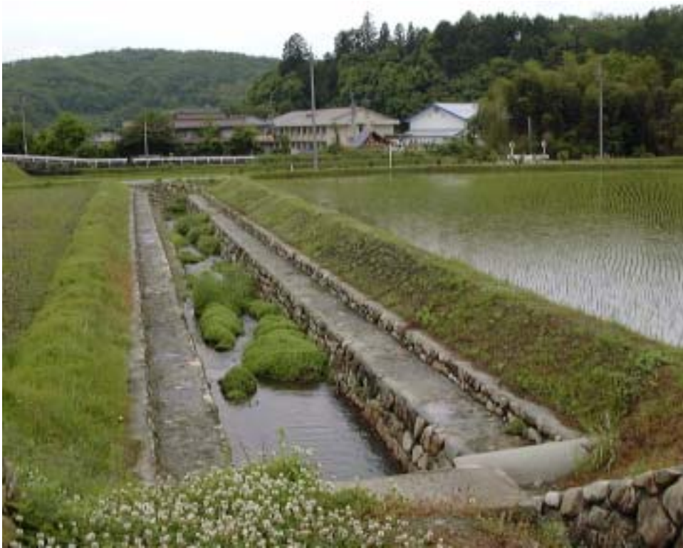
【排水路区間に設けられた遊水池】
