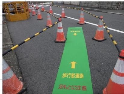
下水道工事は、日々規制や作業場所が変化・移動するため、協力業者、交通誘導員みんなで作業内容、作業手順を把握して作業を開始します。(配置計画を日々作成する。)
