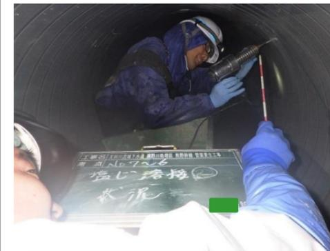
製管工法 接合箇所溶接接続状況
