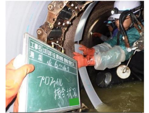
製管工法 プロファイル接合状況
