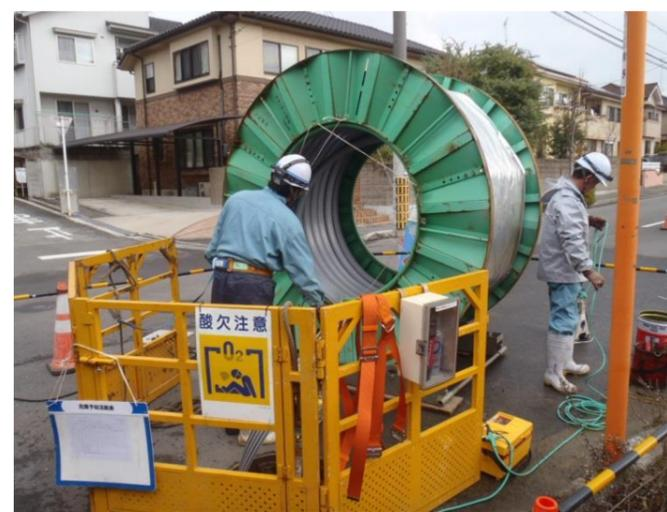
製管工法 施工状況(地上)
