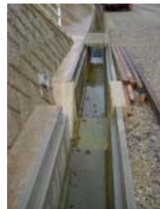
【施工済み写真】
