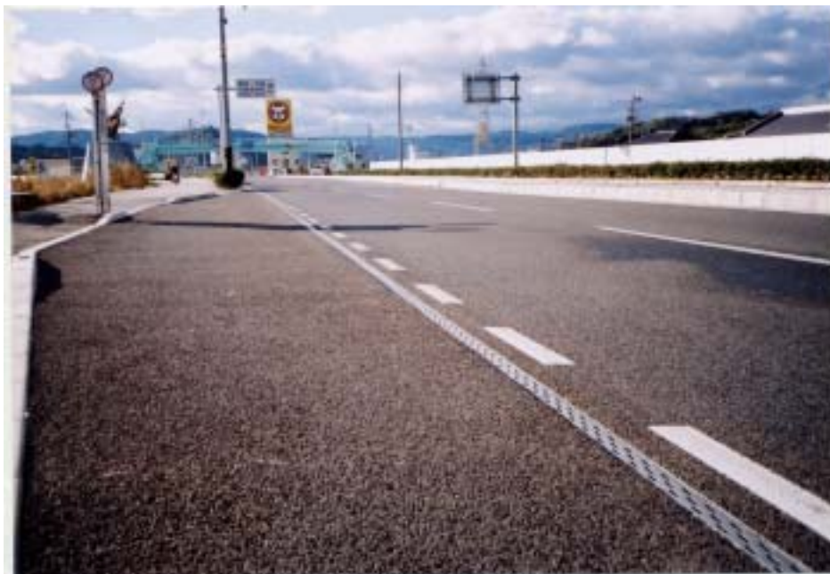
【施工後の状況】
