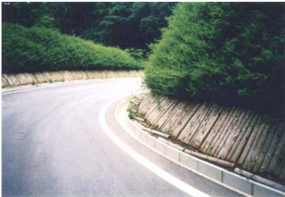
【施工後の状況】
