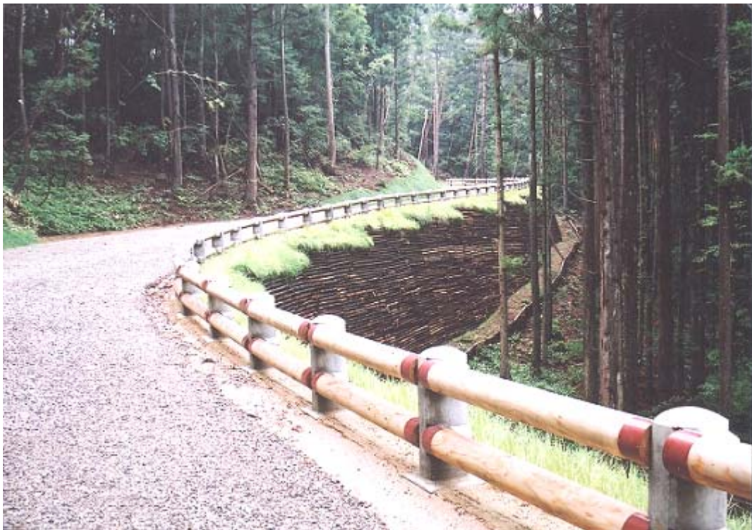
【施工後の状況】
