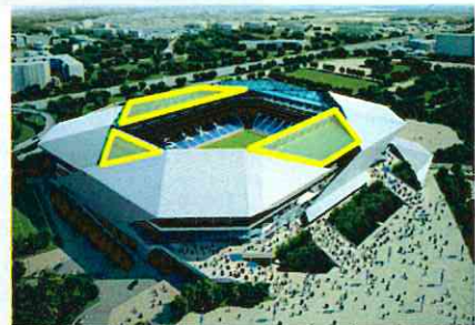
太陽光発電設置場所
