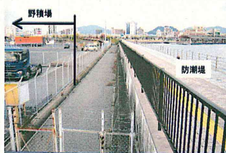
防潮堤、野積場
