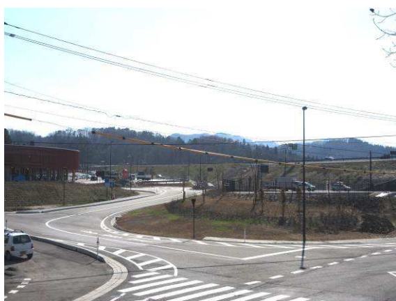
高野インターチェンジ
