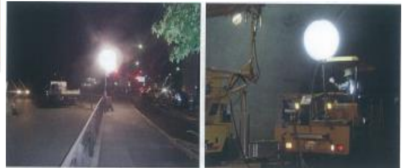
夜間舗装作業
