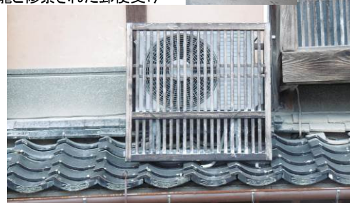
室外機への木格子の取り付け
