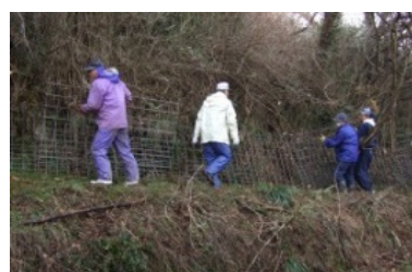
【獣害防止柵の設置】
