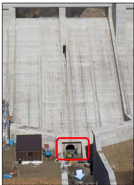
ゲート据え付け完了
