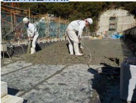
最後の締固め作業
