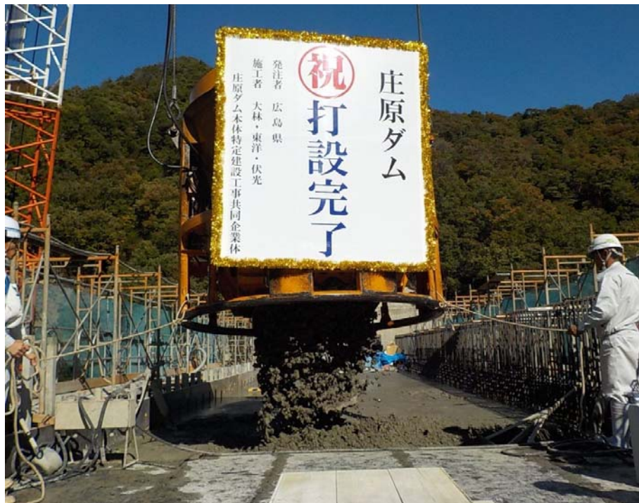
平成27年10月19日撮影(打設完了式)
