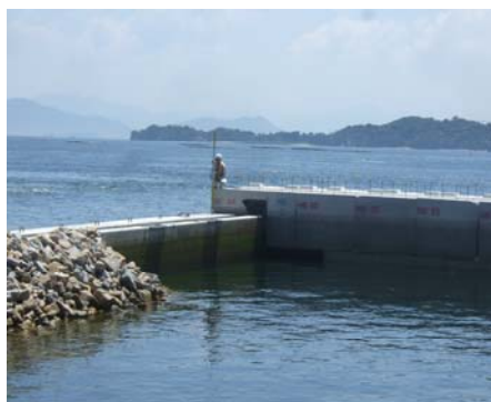
50m先の埋立護岸上のスタッフ
