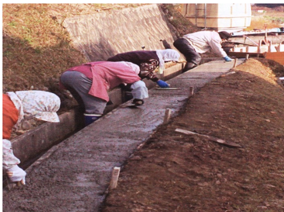
【水路管理用側道の整備】
