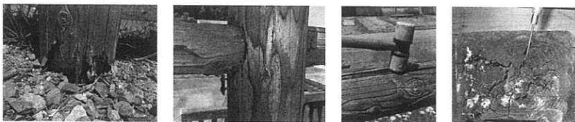
写真 腐朽しやすいところ、たたく点検、ドライバーで刺す内部の腐朽点検
