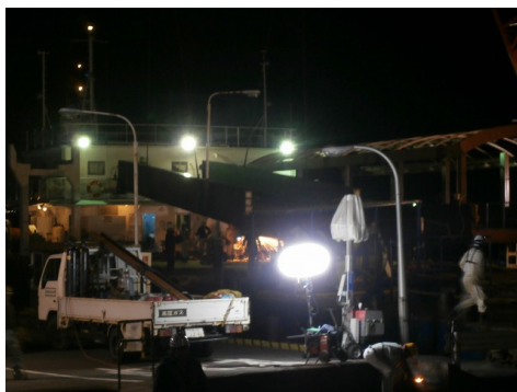
撤去した2本の連絡橋は台船上で改造
