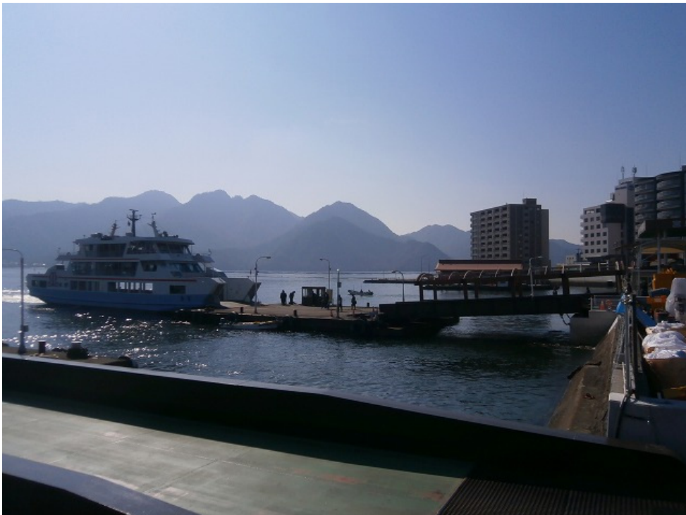
移設が完了した松大旅客フェリー棧橋。手前は松大カーフェリー棧橋の連絡橋。
