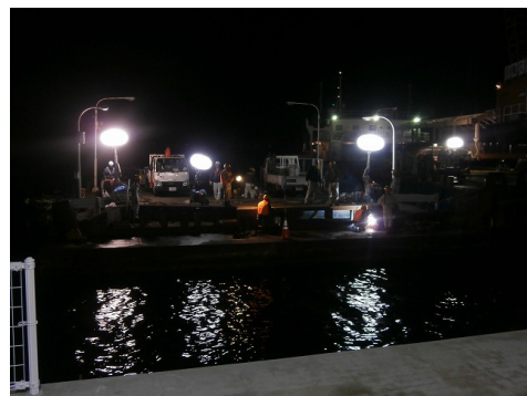
連絡橋撤去後の浮函も改造
