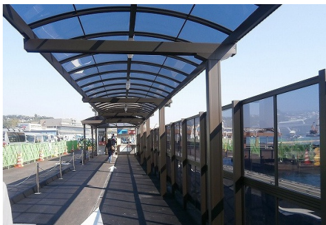
陸上部分は、屋根設置、舗装等を行い、通路を整備しています
