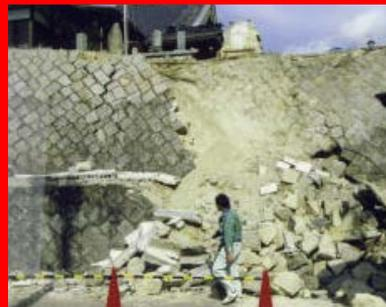
平成13年3月に芸予地震により擁壁が崩壊(写真は呉市)
