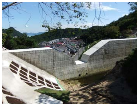
↑ 平成 22 年の災害を踏まえ整備した, 市街地を保全する砂防えん堤 (呉市)
