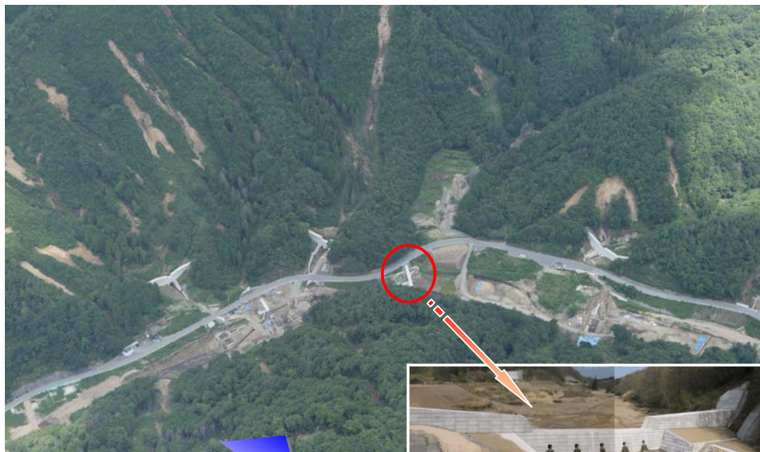
↓ 平成 22 年の災害を踏まえ整備した, 砂防えん堤群 (庄原市)
