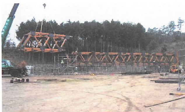
写真2 再組立て状況
