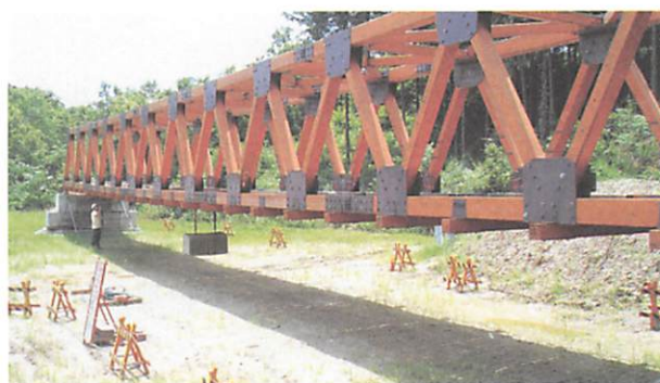
写真3 荷重実験状況
