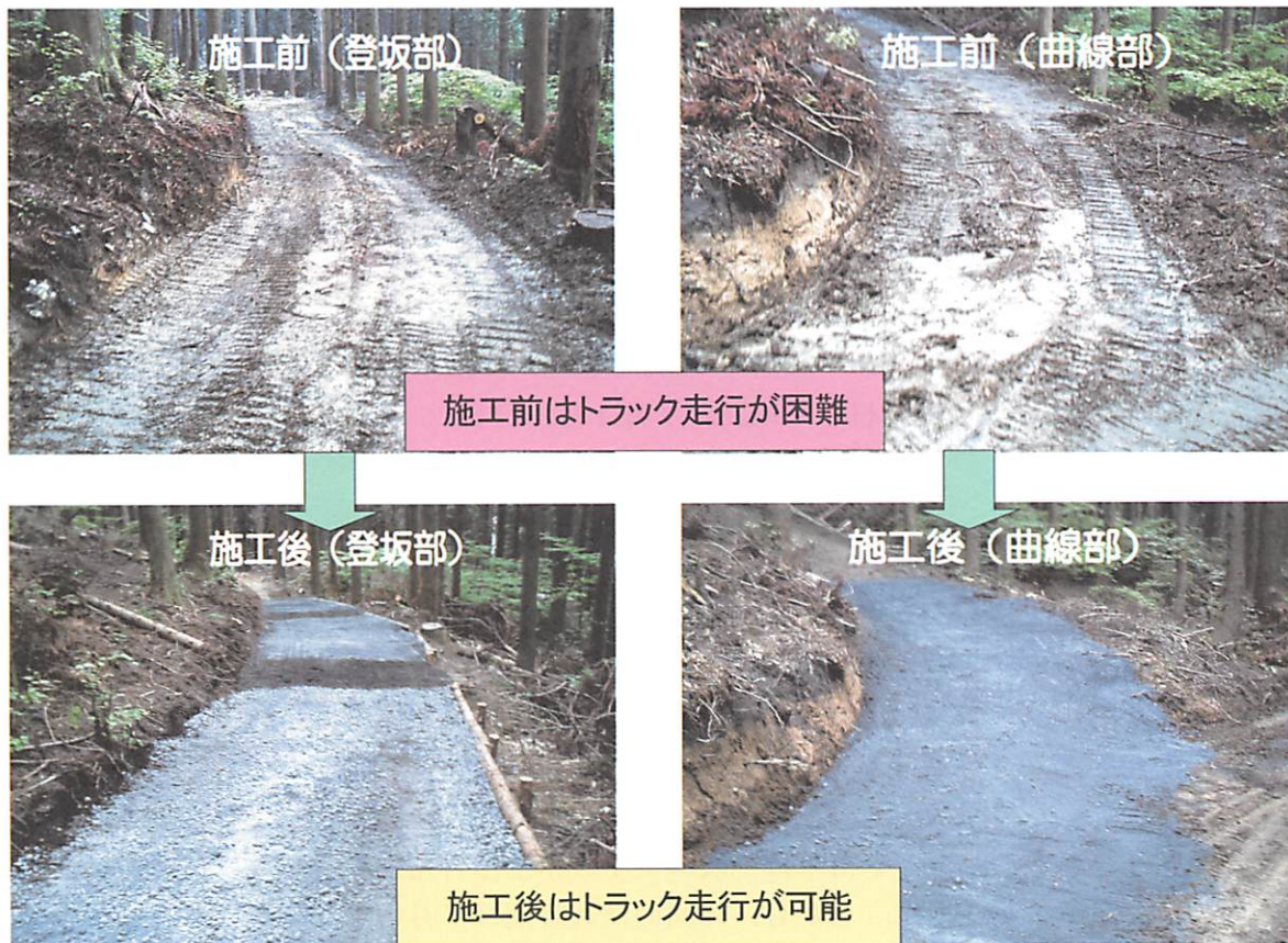
写真一1 試験施工前と施工後の路面状況
