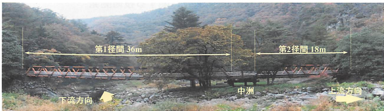
写真1 山野峡自然公園内へ架設当時の「かっぱ橋」
