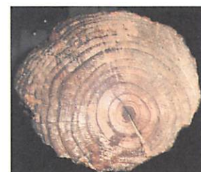
写真4 樹脂を浸み込ませたスギ腐朽材
