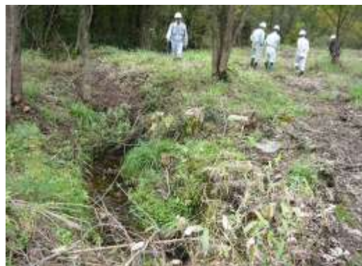
■明渠の施工状況
