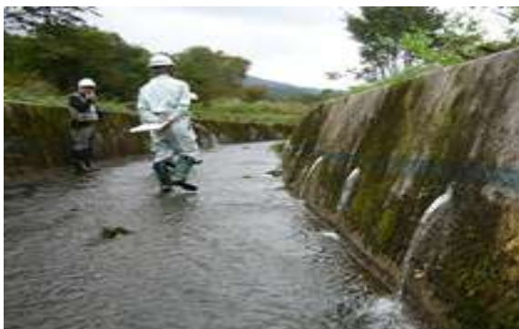
■河川の三面張り、排水暗渠の施工状況
