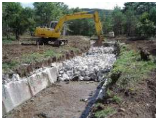
■三面張り河川のコンクリート取り壊し、埋設工事
