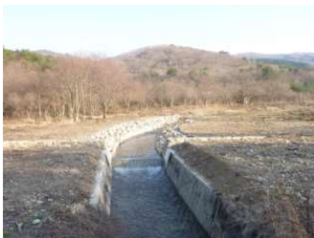
■ 下流端部の堰堤 中間部に設けた土砂溜りの観察により、最小規模の堰堤に到着した
