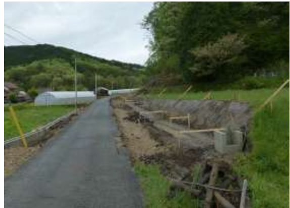
■町道区間の拡幅改良工事
