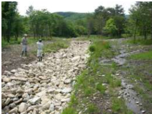
■河川水が伏流している状況 (完成当初)
