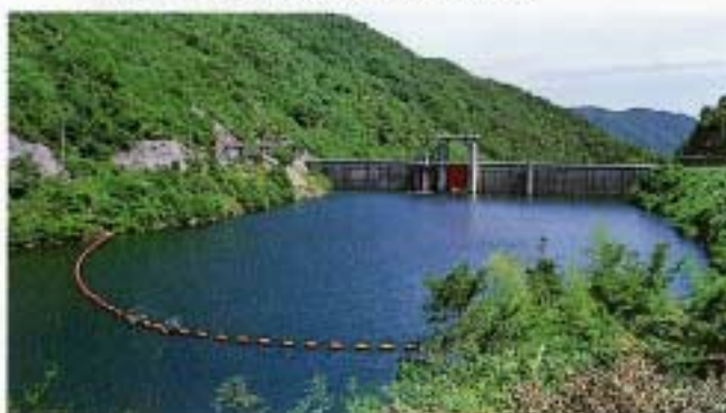
▲ 流木止網場施設
